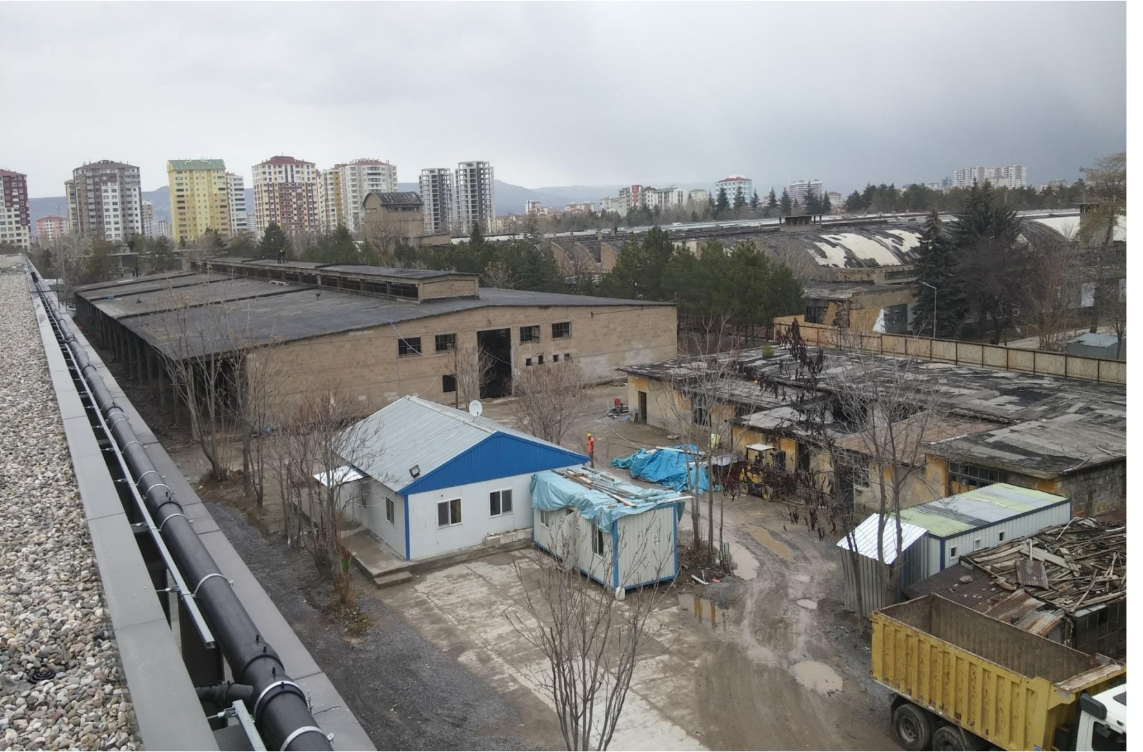
Mamul Ambarı ve İtfaiye Binası Eski Hali
